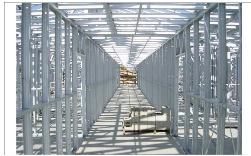
شکل ۲: دیوار باربر در سازه LSF
